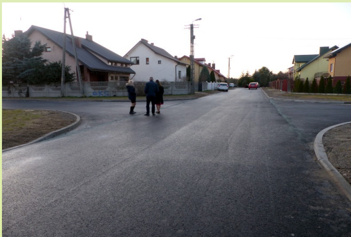
3. Przebudowa dróg na Osiedlu Leśnym w Klukach (ul. Jesionowa, ul. Spacerowa)
