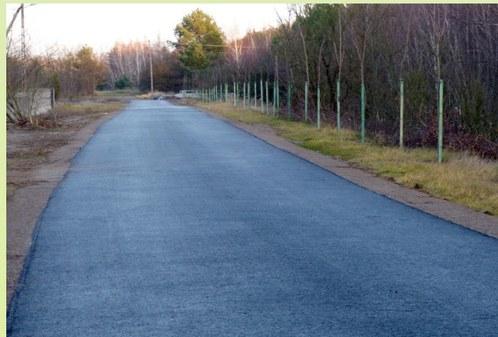
4. Przebudowa drogi w Kuźnicy Kaszewskiej
